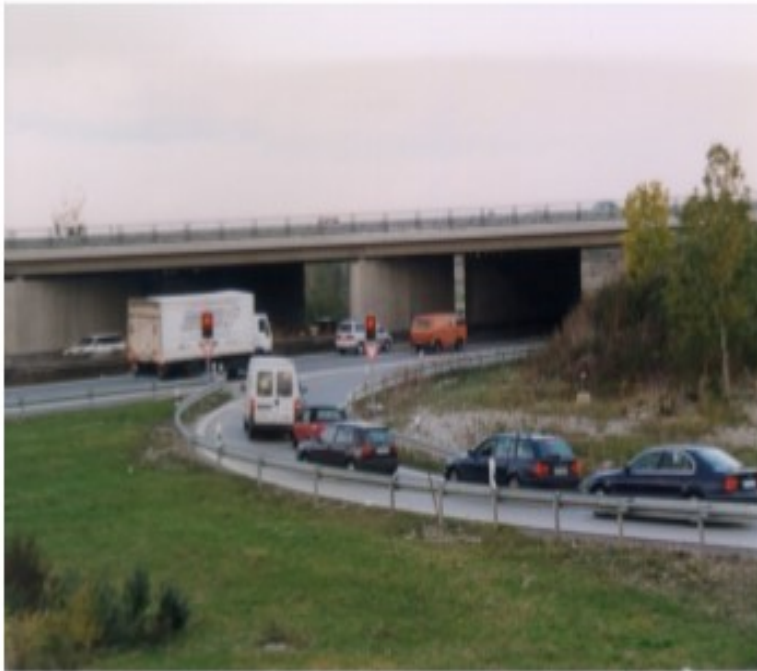
Bild 11: Zuflussregelungsanlage an einer Anschlußstelle
